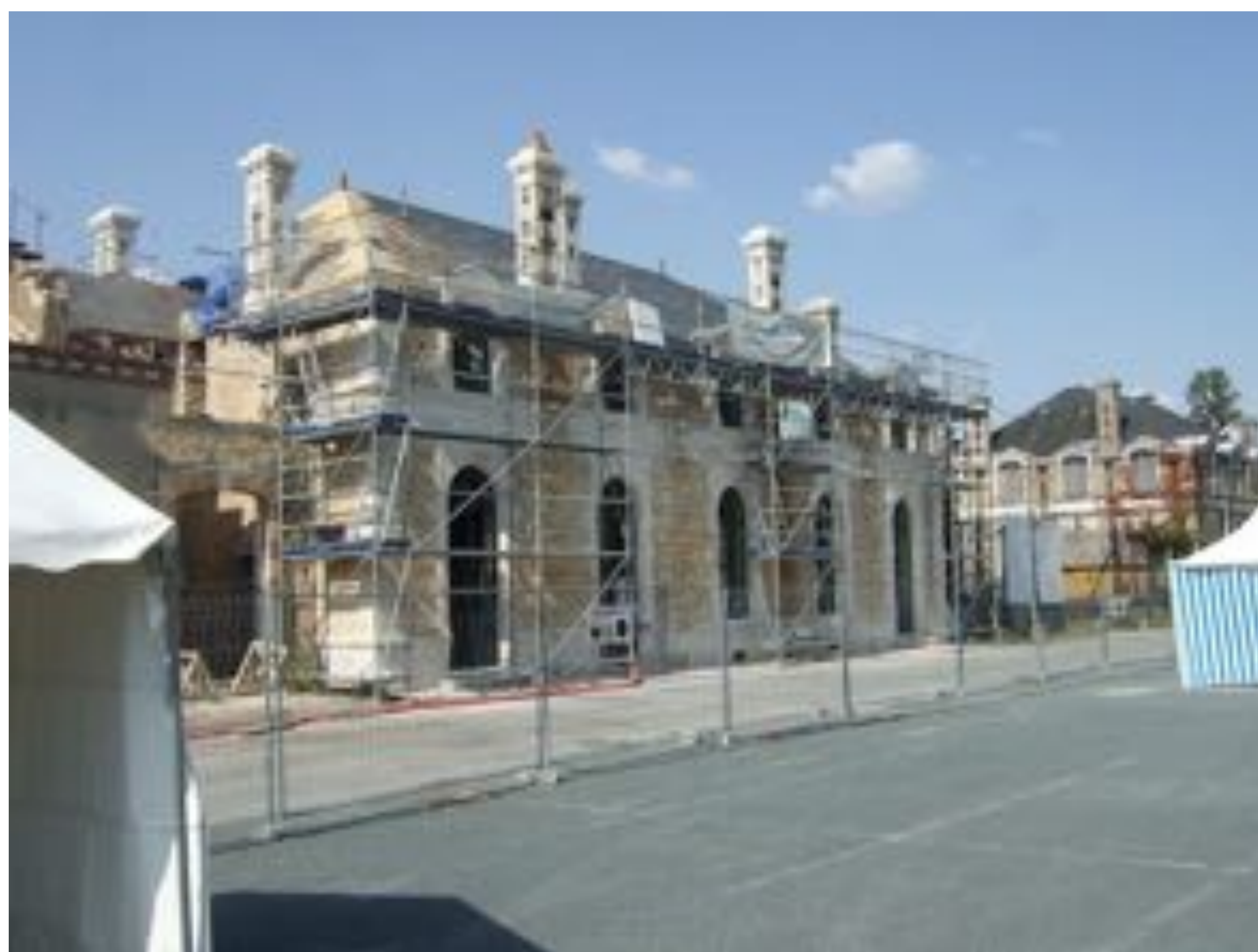
Chantier de construction de l'Ecole HEI Campus Centre dans l'aile Ouest du site BALSAN réhabilité
