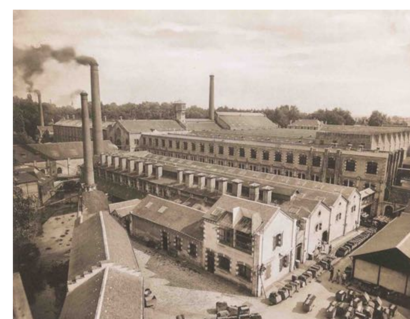
Manufacture BALSAN construite en 1862-69
