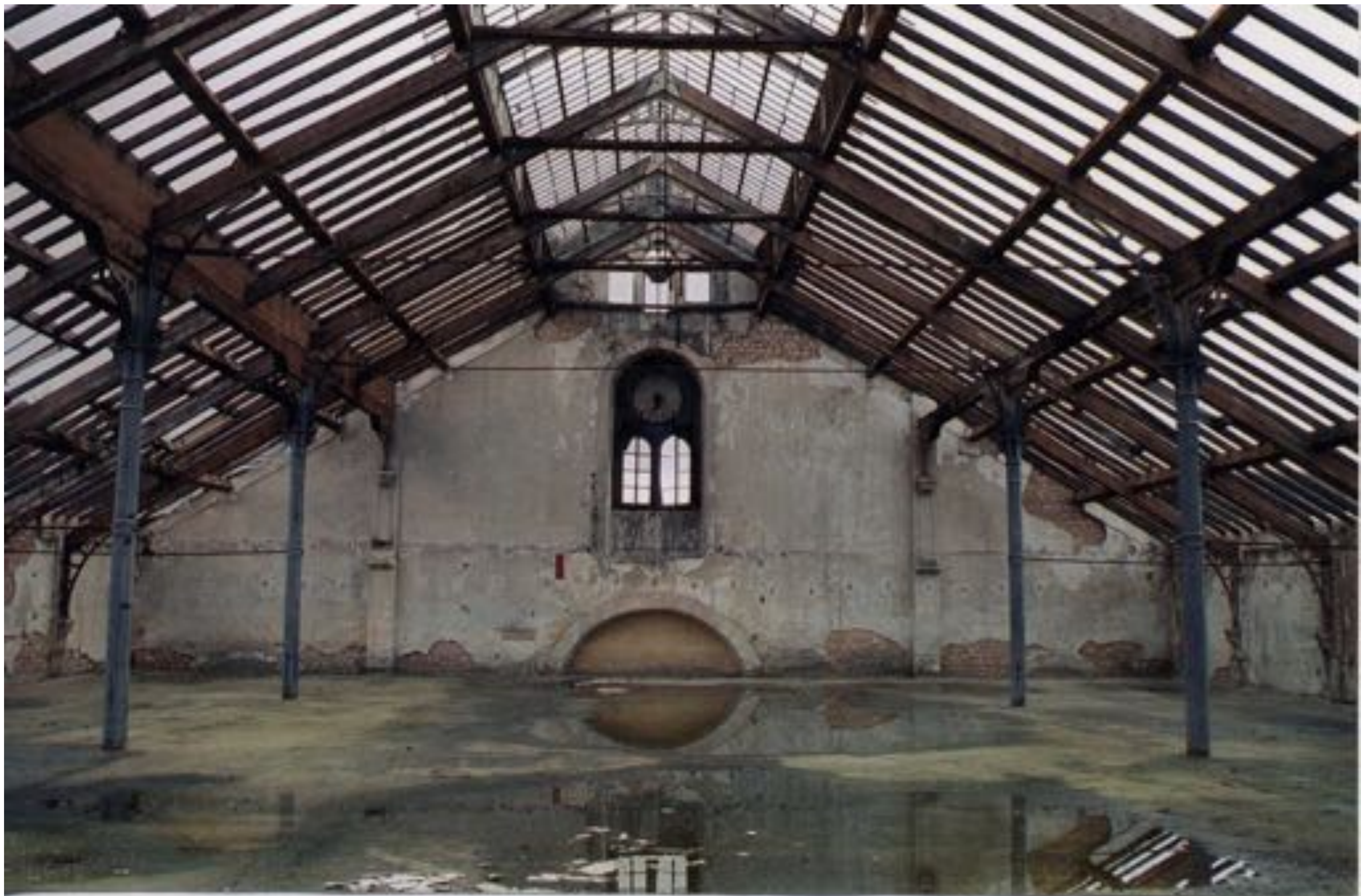
Toiture du Bâtiment de l'Horloge en 2004
